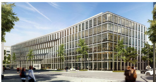
Das von CA Immo entwickelte Berliner Bürogebäude MY.B wurde im 1. Quartal 2020 fertig gestellt und in den Bestand übernommen.
