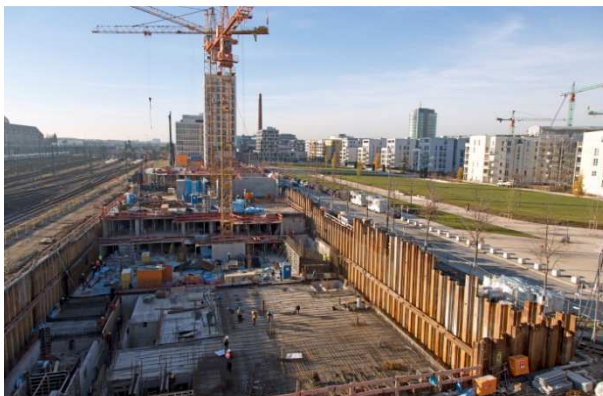
Baustelle des Kontorhaus im Münchner Arnulfpark
